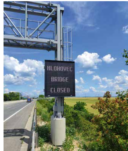
Plnomatický LED panel na zobrazovanie výstražných značiek a informácií
